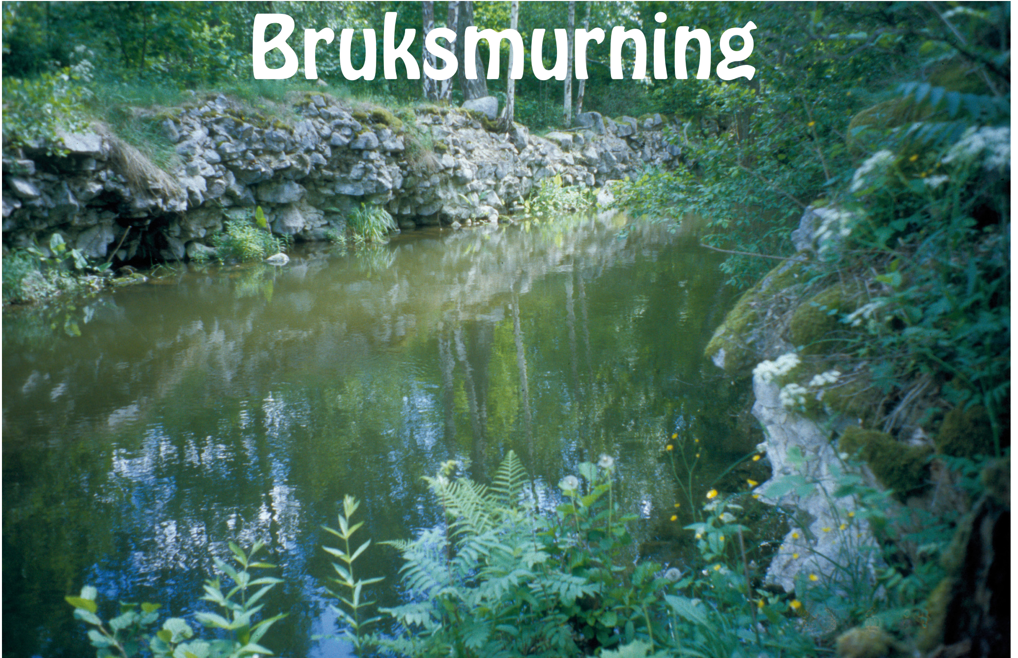
Västmanlands sluss i Hjälmare kanal (1629-39 reparerad 1772).
