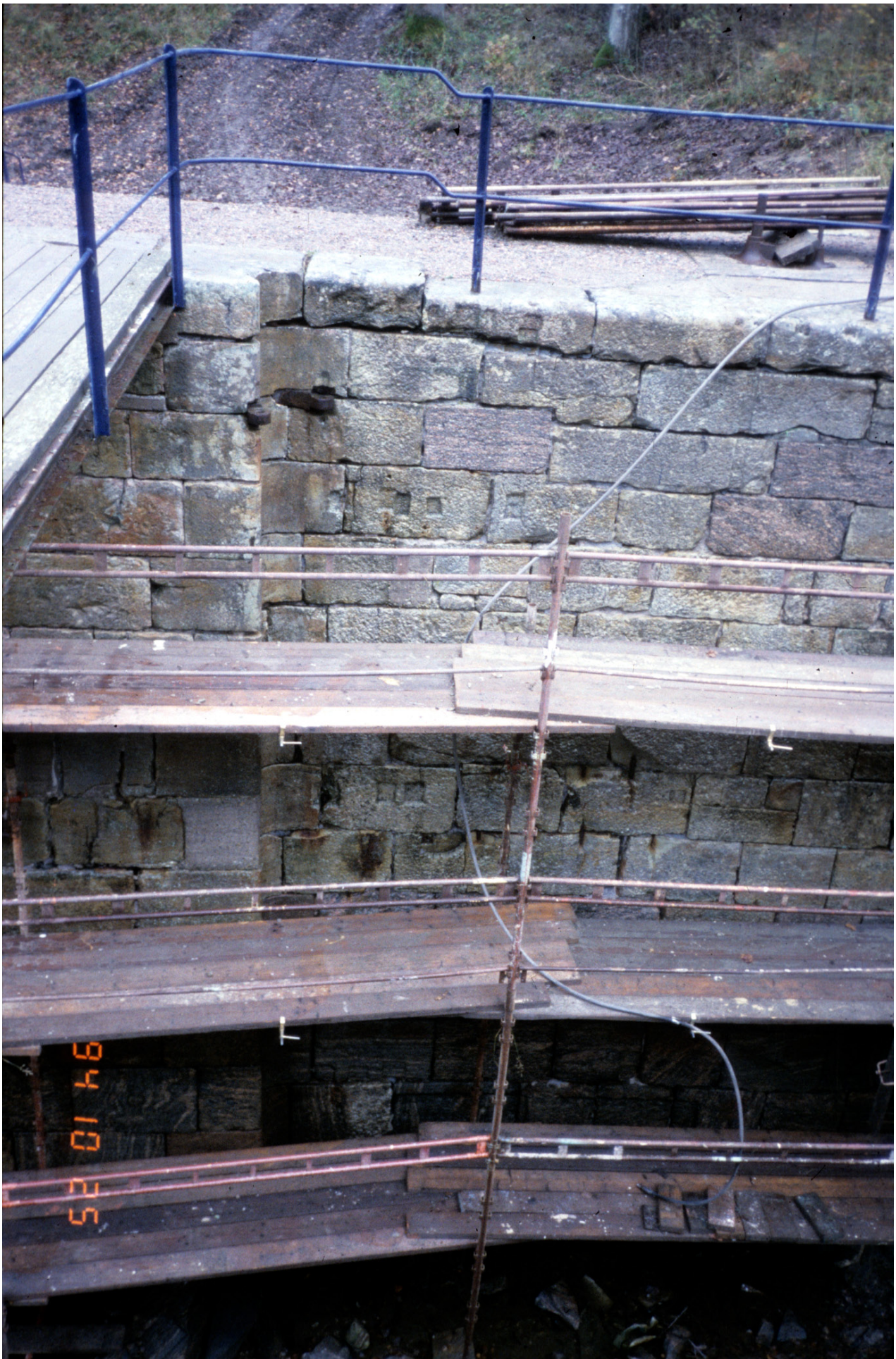
Uttilad befintlig fog.
