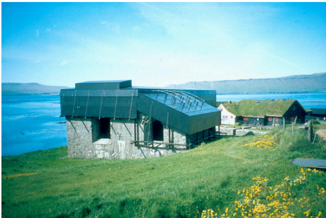
Fig. 5. Domkyrkoruinen i Kirkjubøur Färöarna. Vy åt nordost. Skyddsintäckningen tillkom 2004. Foto: Sölve Johansson 2007.
