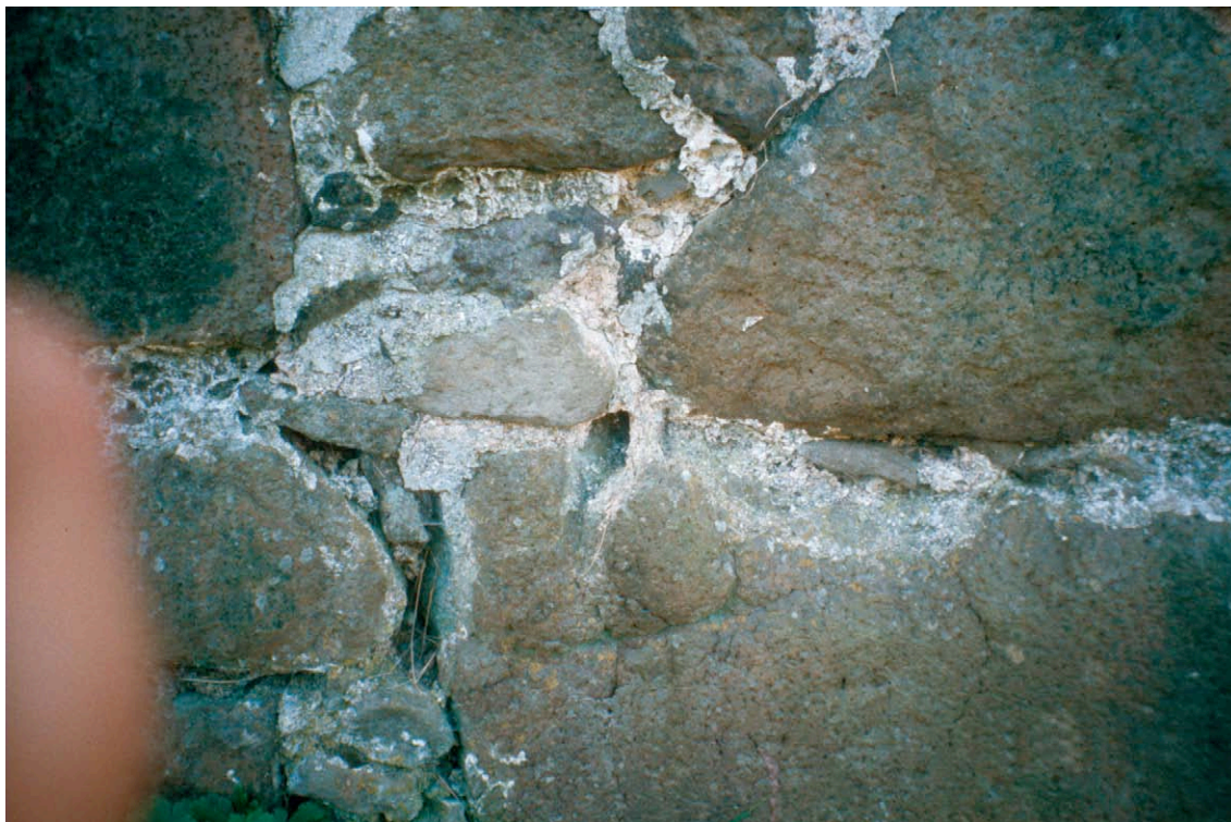
Fig. 69. Munkastovan på Tinganes i Torshavn Färöarna. Bruksprov Munk Fö 3. Mur/fogbruk. Nordmuren, utvändigt, mellan stenskärv "klipur". Foto: Sölve Johansson 2007.
