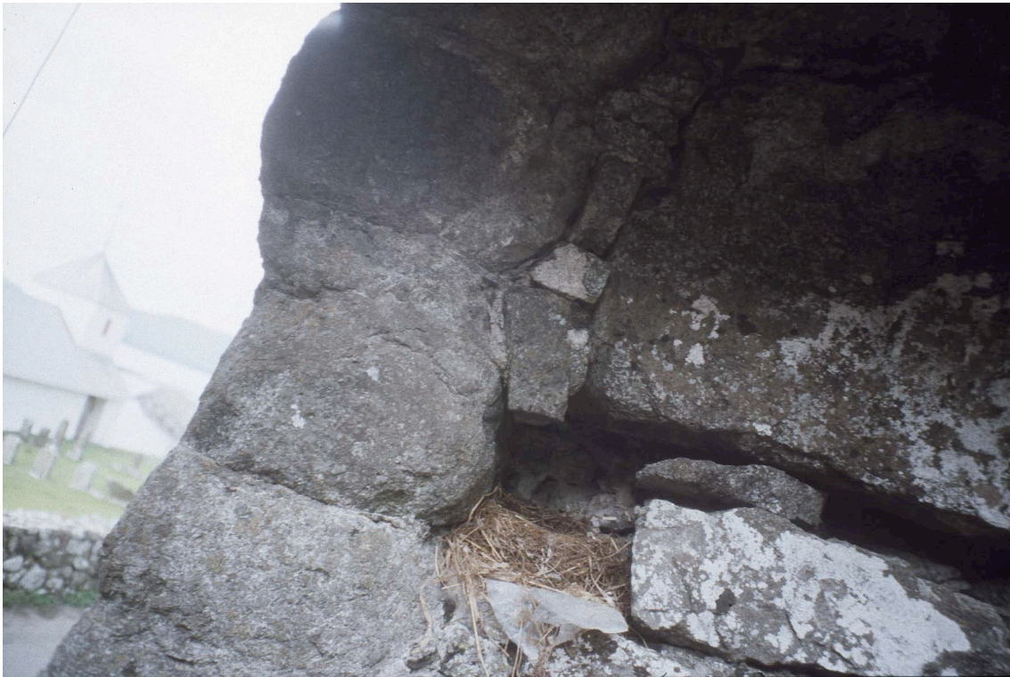
Fig. 10. Domkyrkoruinen i Kirkjubøur Färöarna. Bruksprov Dom Fö 1 Murbruk. Västmuren invändigt, bomhål/fågelbo strax norr om västportalen ca 3,5 meter från marken. Foto: Sölve Johansson 2007.
