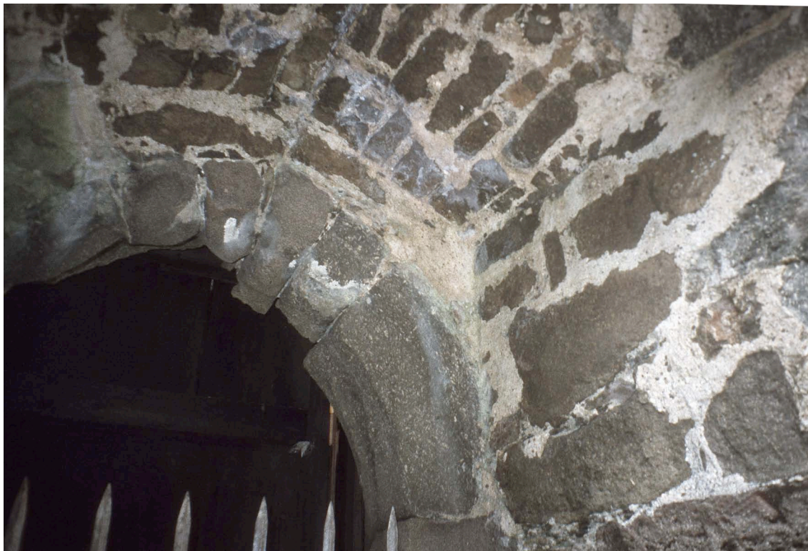
Fig. 20. Domkyrkoruinen i Kirkjubøur Färöarna. Bruksprov Dom Fö 4. Fog/ putsbruk (utstruken fog). Sydmuren, invändigt, ovansidan östra portalen. Jmf. prov 9 1989. Foto: Sölve Johansson 2007.
