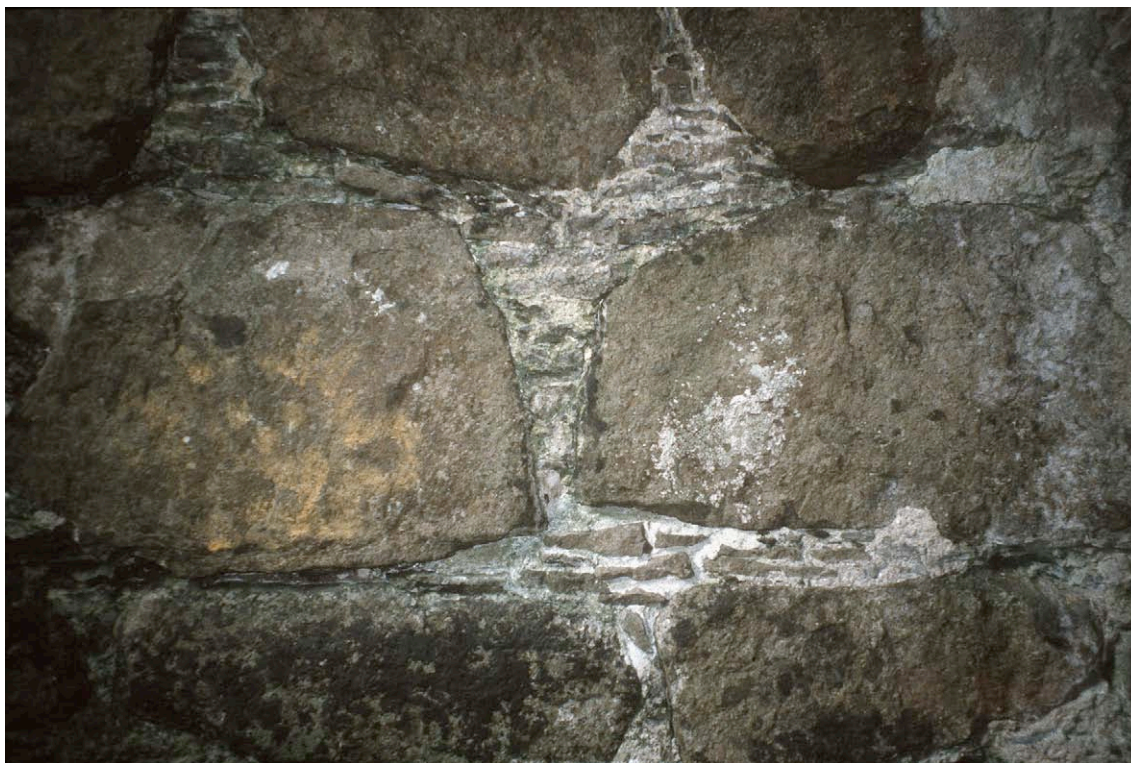
Fig. 28. Domkyrkoruinen i Kirkjubøur Färöarna. Bruksprov Dom Fö 6. Fogbruk (utstruken fog). Sakristians sydmur, invändigt, i mitten ca 1,5 meter från marken, mellan stenskräv "klipur". Foto: Sölve Johansson 2007.
