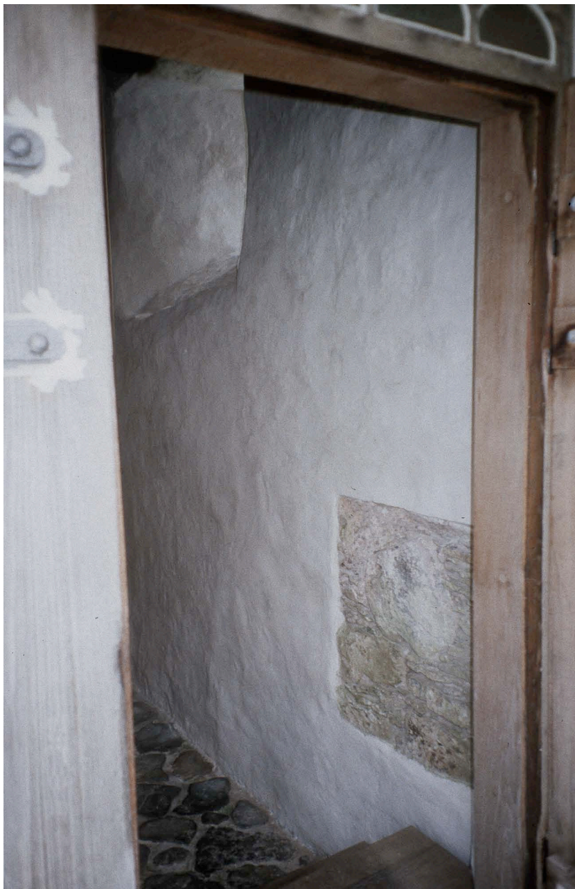
Fig. 54. Sockenkyrkan i Kirkjubøur Färöarna. Bruksprov Sock Fö 1. Mur/fogbruk. Västmuren, invändigt, från det oputsade partiet vid ingången till kyrkan. Jmf prov 16 1989. Foto: Sölve Johansson 2007.
