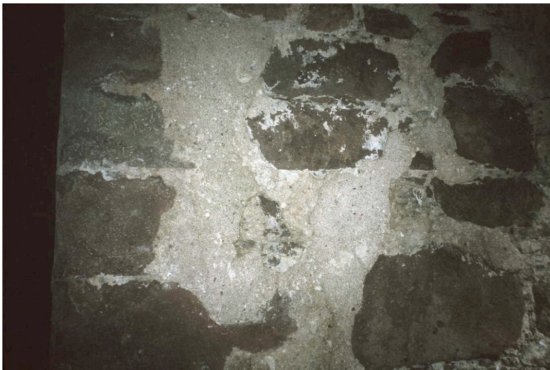
Fig. 30. Domkyrkoruinen i Kirkjubøur Färöarna. Portalen mellan kyrkorummet och sakristian, östra smygen, med välbevarat putsbruk med två skikt. Foto: Sölve Johansson 2007.
