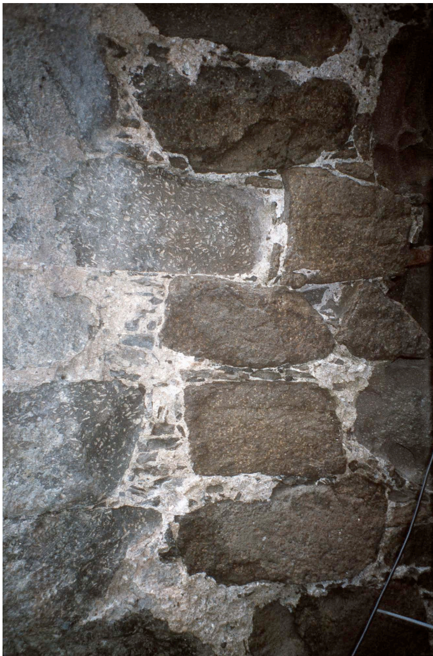
Fig. 14. Domkyrkoruinen i Kirkjubøur Färöarna. Bruksprov Dom Fö 2. Fog /putsbruk (utstruken fog). Sydmuren, invändigt, östra smygen västra portalen, mellan stenskärv "klipur". Jmf prov 10 1989. Foto: Sölve Johansson 2007.
