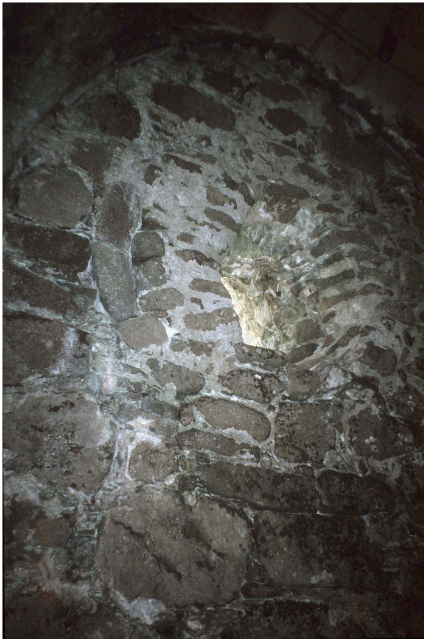
Fig. 33. Domkyrkoruinen i Kirkjubøur Färöarna. Bruksprov Dom Fö 8. Murbruk. Sakristians västmur, invändigt i sekundärt igensatt fönsteröppning. Foto: Sölve Johansson 2007.
