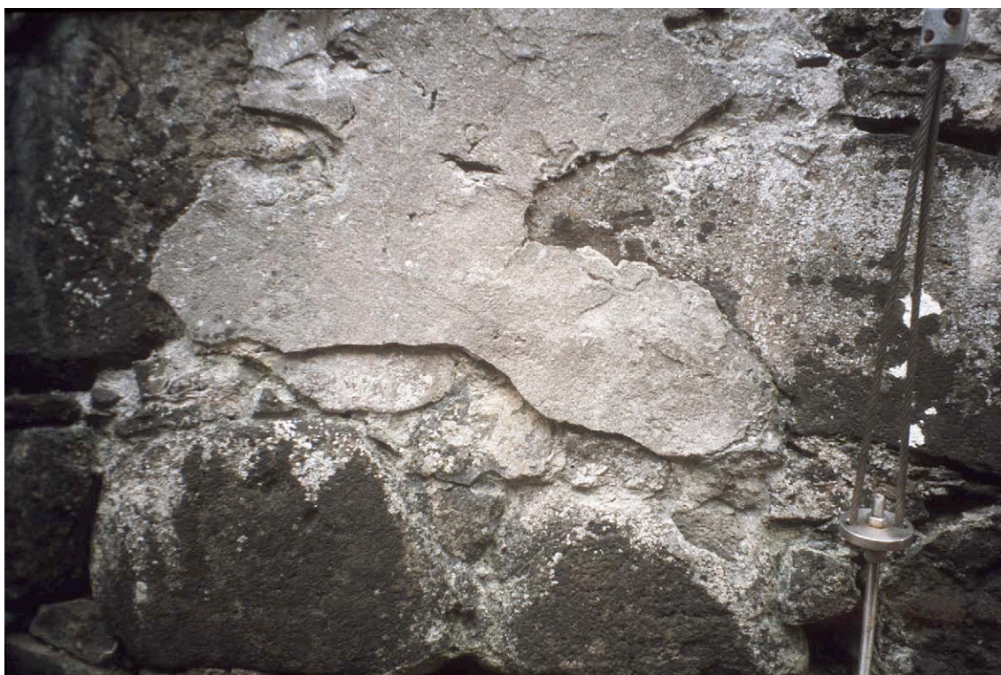
Fig. 70. Domkyrkoruinen i Kirkjubøur Färöarna. Putsbruk, heltäckande på stenytor, sydmuren, invändigt öster om västportalen ca 1 meter från marken. Foto: Sölve Johansson 2007.
