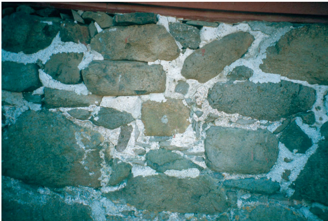
Fig. 68. Munkastovan på Tinganes i Torshavn Färöarna. Bruksprov Munk Fö 1 och 2. Mur/fogbruk. Norrmuren, utvändigt, mellan stenskärv " klipur ". Foto: Sölve Johansson 2007.
