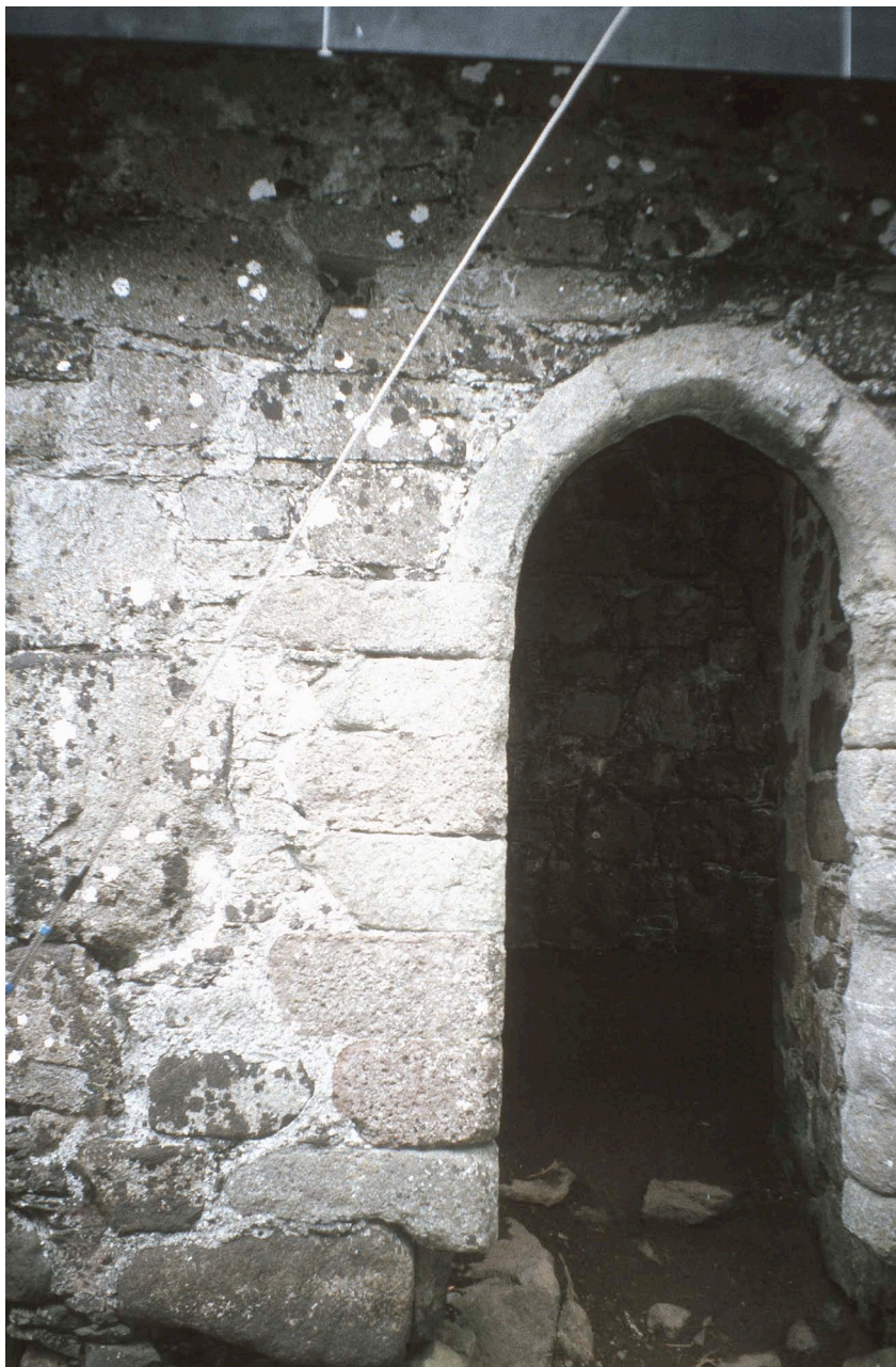
Fig. 39. Domkyrkoruinen i Kirkjubøur Färöarna. Bruksprov Dom Fö 10. Murbruk. Nordmuren, invändigt, bomhål väster om sakristiportalen ca 3,5 meter från marken. Foto: Sölve Johansson 2007.
