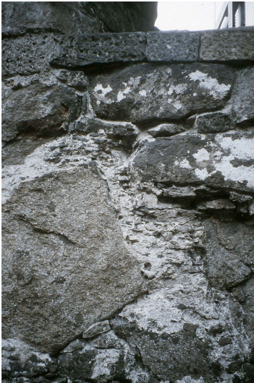
Fig. 17. Domkyrkoruinen i Kirkjubøur Färöarna. Bruksprov Dom Fö 3. Fog/ putsbruk (utstruken fog). Sydmuren, invändigt, i mitten ca 1,5 meter från marken, mellan stenskärv "klipur" . Foto: Sölve Johansson 2007.
