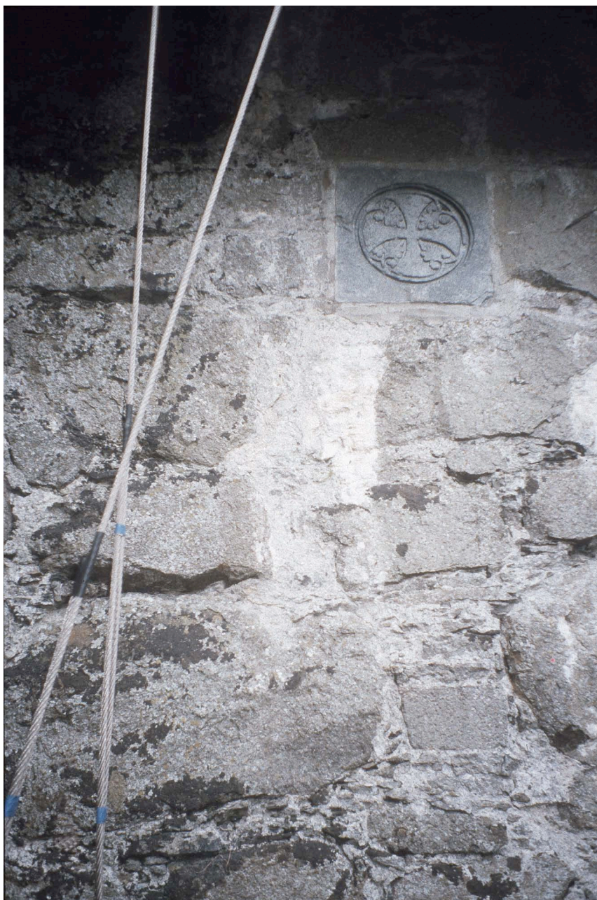
Fig. 42. Domkyrkoruinen i Kirkjubøur Färöarna. Bruksprov Dom Fö 11. Putsbruk med två skikt? Östmuren, invändigt, vid invigningskors åt nordöstra hörnet ca 2 meter från marken. Foto: Sölve Johansson 2007.
