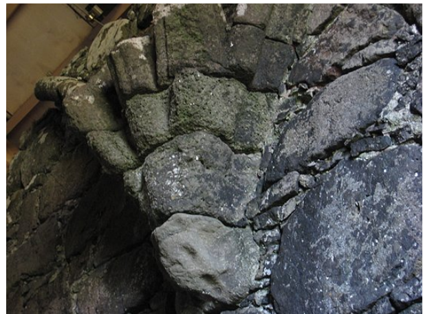
Figur 1.4. Eksempel på nedbrydning af konsol for krydshvælv. Slutstenen har muligvis været udformet som et ansigt.
