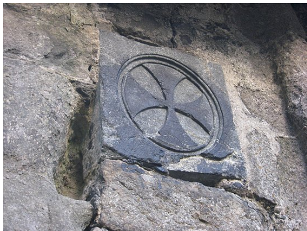
Figur 1.8. Indvielseskors udført af vejrbestandig klæbersten. Mekanisk skade fornedden skyldes antagelig forsøg på at fjerne stenen.
