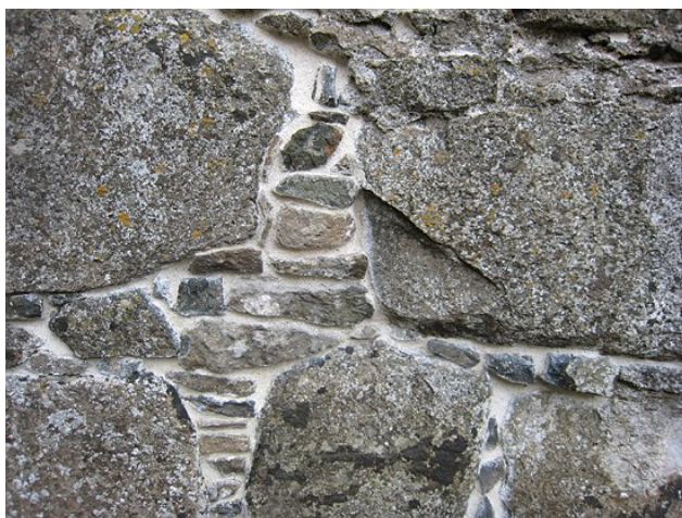
Figur 5.2. Eksempel på restaurering af fuger på nordsiden af Muren. Mørtlen er baseret på hydraulisk kalk fra St. Astier.
