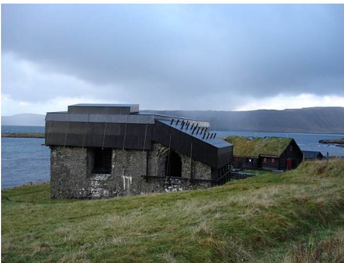
Figur 3.1. Domkirkeruinen på Kirkjubøur set fra nordøst. Den midlertidige afskærmning er udført af sortmalet krydsfiner.
