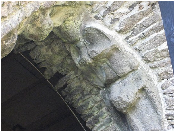
Figur 1.3. Eksempel på nedrydning af profilerede vinduesindfatninger.
