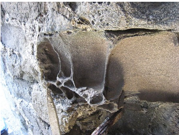
Figur 1.1. Eksempel på dybtgående forvitring (alveoledannelse) af basalt som følge af saltkrystallisation
